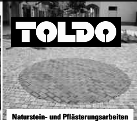
Naturstein- und Pflasterungsarbeiten
