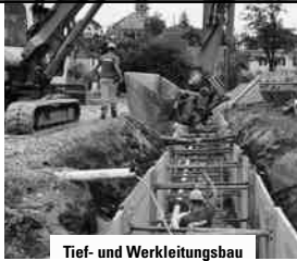
Tief- und Werkleitungsbau
