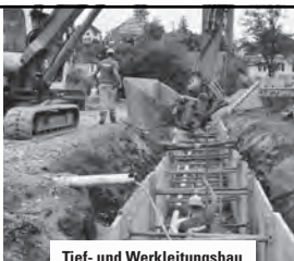
Tief- und Werkleitungsbau
